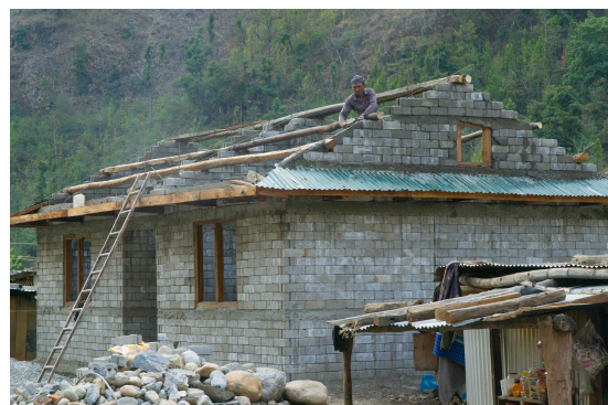
(d) Laying of roof beams on gable wall.
