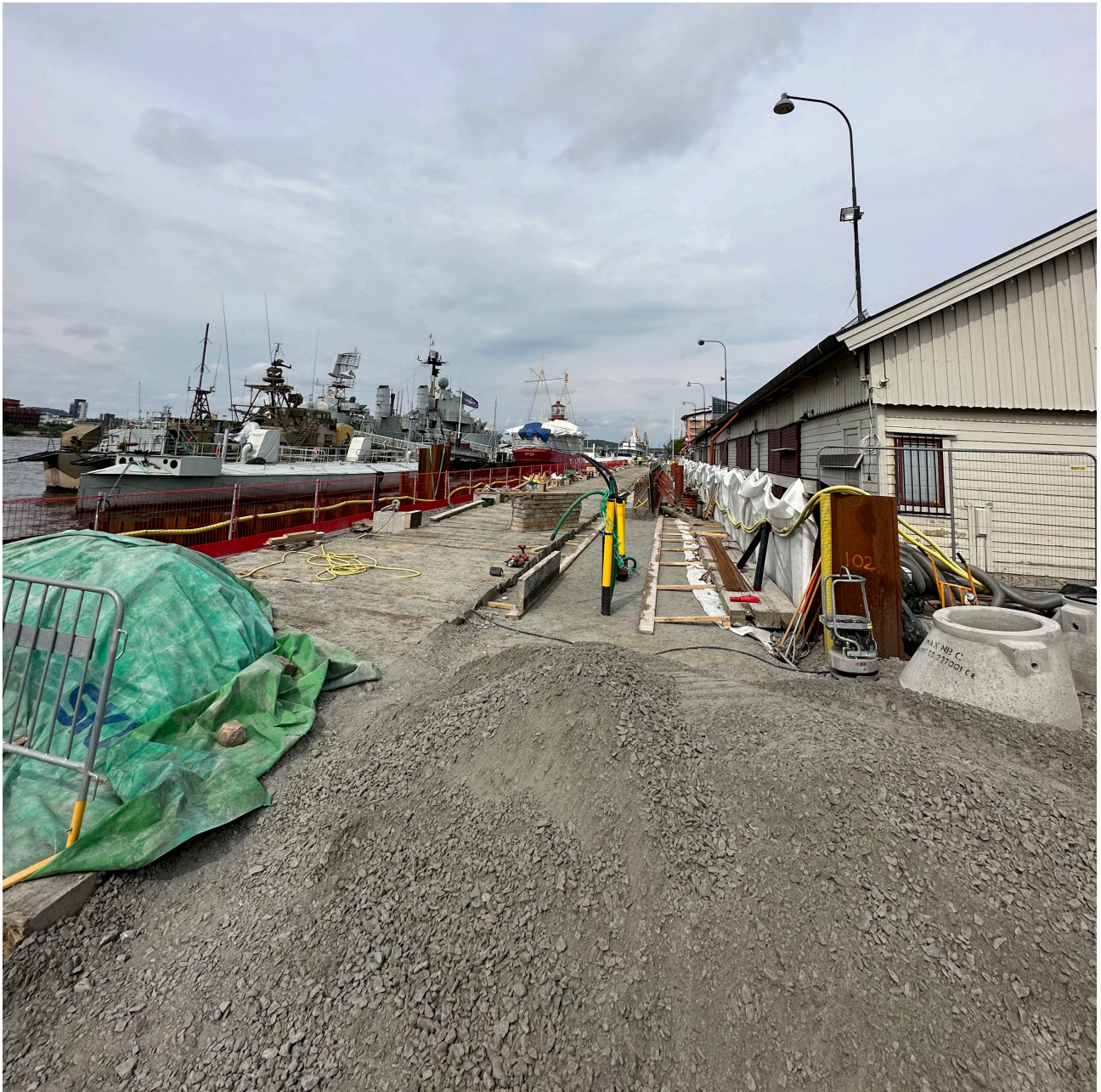
Figur 22: Bild på arbetsområdet för en 120 meter lång kajkonstruktion.
