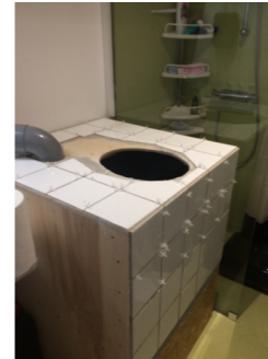
Putting tiles upp
