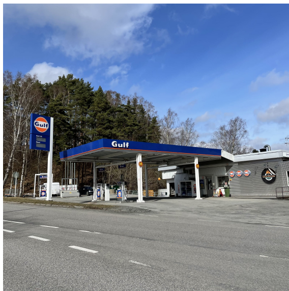
Figur 4.3: Bensinstation söder om Backa grundvattentäkt.
