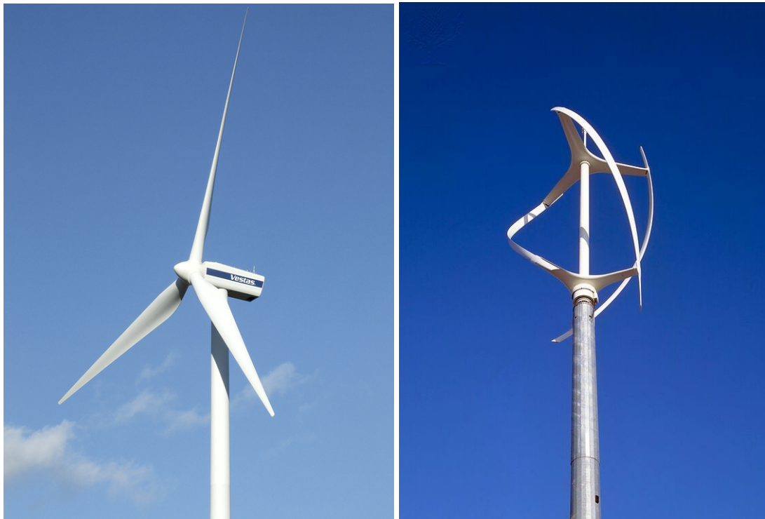
(a) Horisontalaxlat vindkraftverk (Britannica ImageQuest, Encyclopædia Britannica, ca 2017). (b) Vertikalaxlat vindkraftverk (Britannica ImageQuest, Encyclopædia Britannica, 2016).
