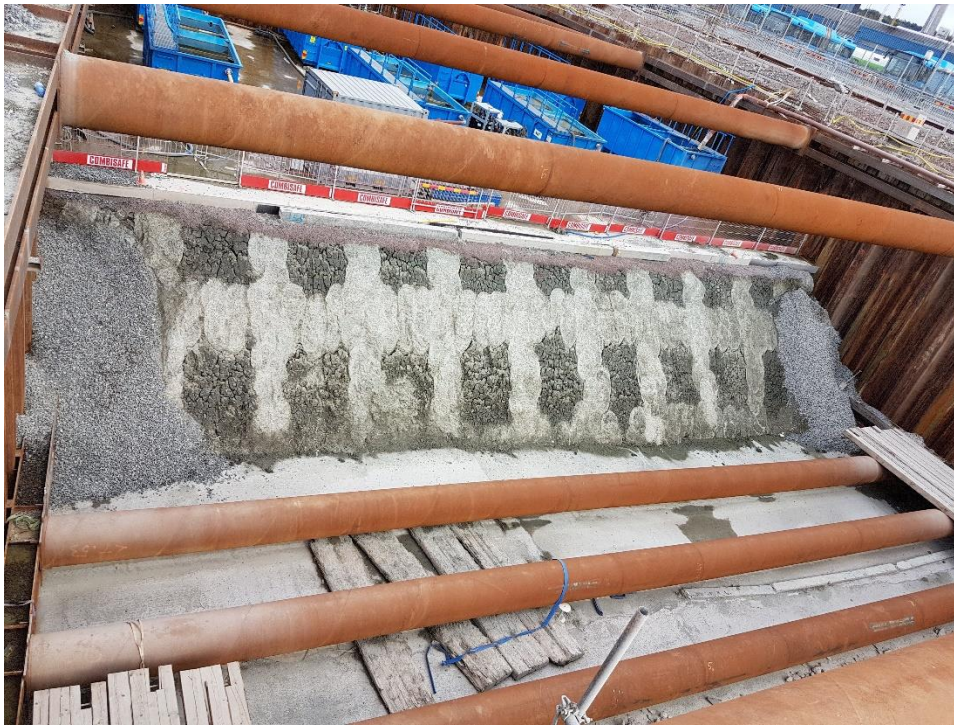
Figure 2.2 Lime cement grid in Västlänken E02 Centralen. (Jonatan Isaksson, private photo)
