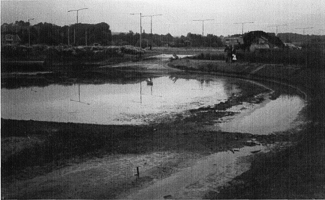
Bild 11. Delen med betongbotten, samt det lilla parti med lera som finns mellan betong och makadambottnarna. Observera sedimentsträngen.
