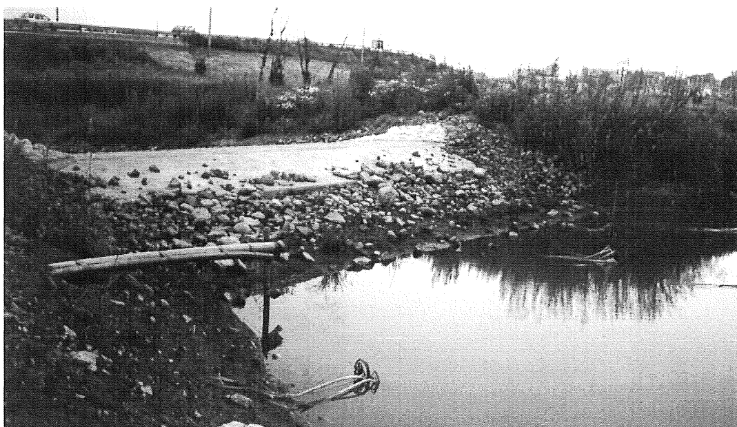
Bild 8. Skibordet när dammen var tömd, ledningen in till mätbrunnen syns i bilden.
