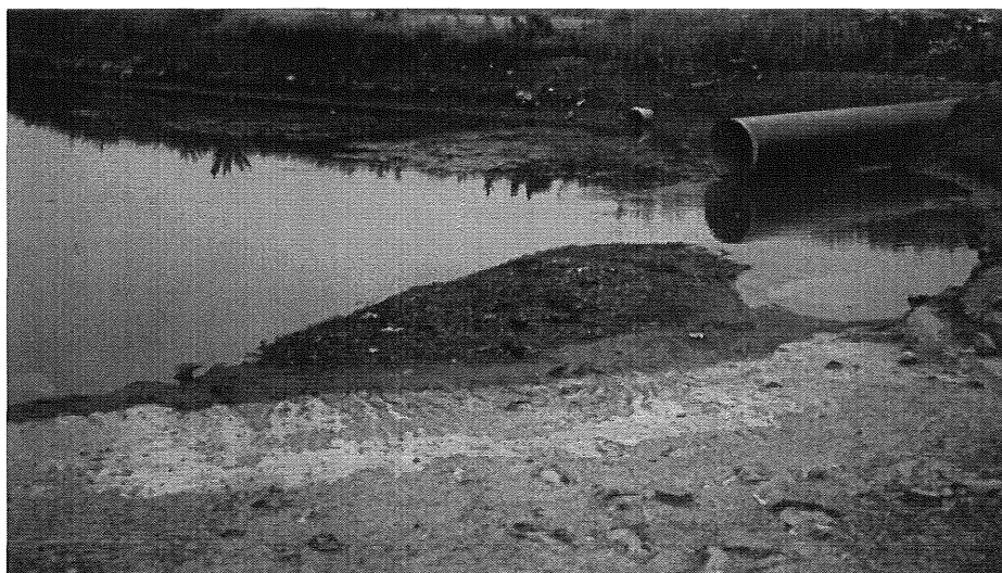
Bild 14. Sedimentsträngar kring inloppsörret.
