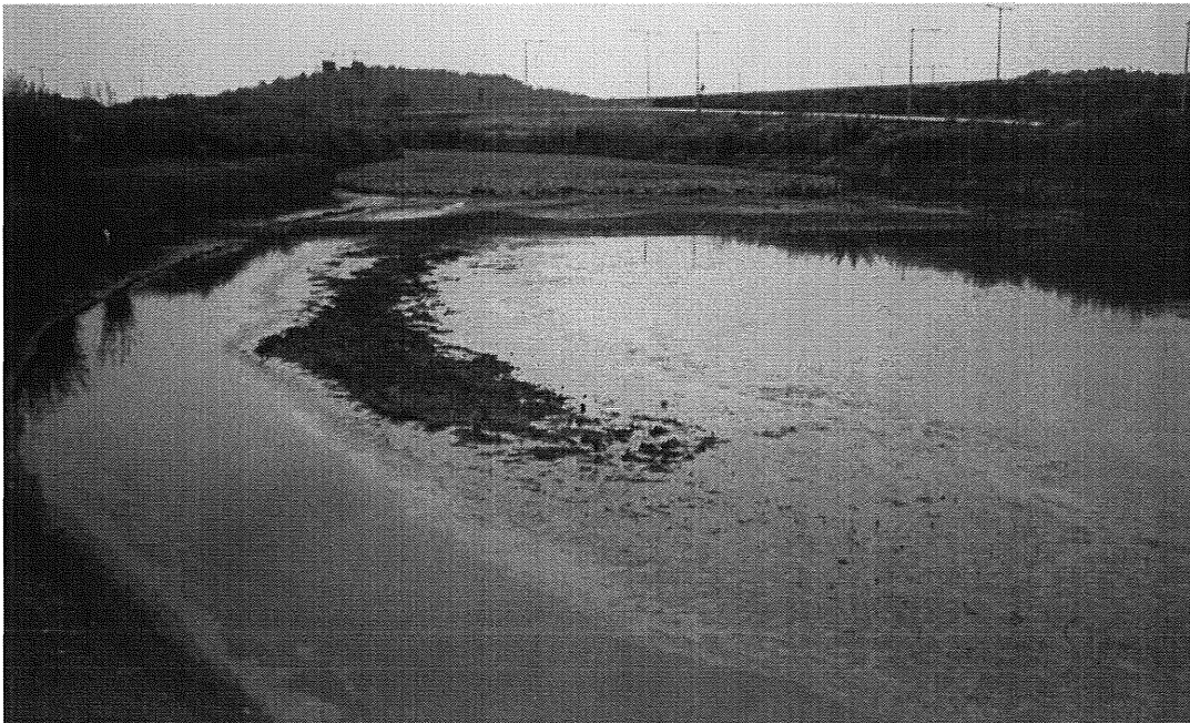
Bild 12. Sedimentsträng på betongbotten, i bakgrunden syns övergången betong till lera till makadam.
