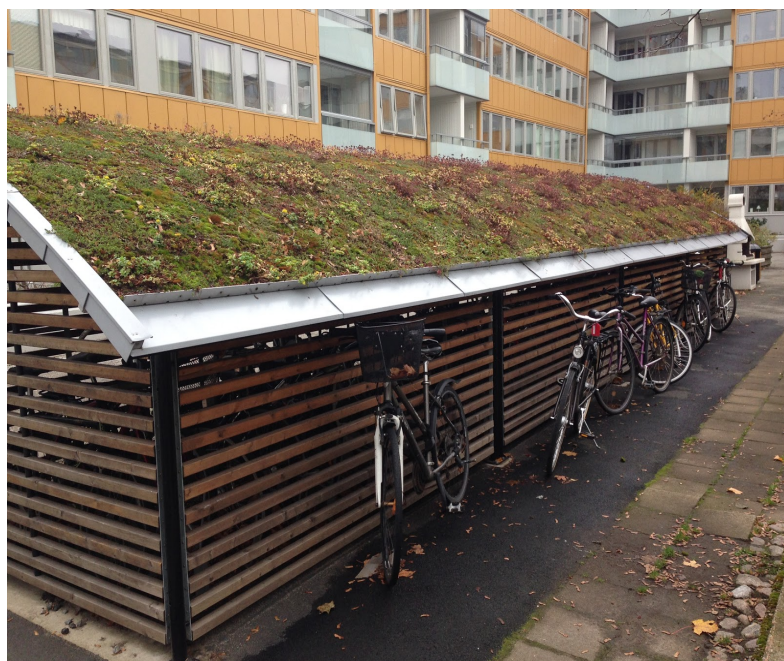
Figur 3: Grönt tak på cykelskjul. Författarnas egen bild.
