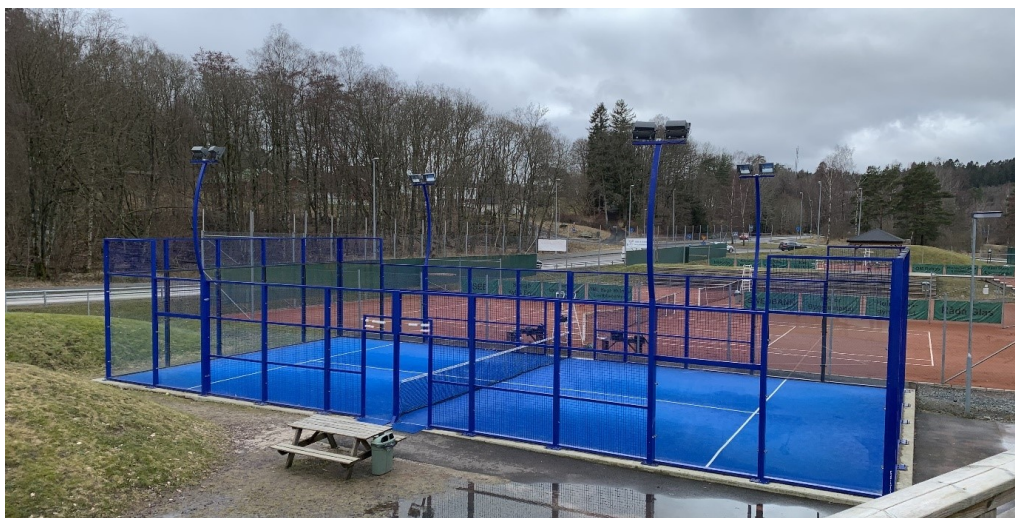
Figur 2.3.1: Padelbana i Pixbo, med långsidans konstruktion enligt variant 1. Om den hade byggts som variant 2 hade metallgallret byggts högre på långsidorna, så att omslutande väggar runt padelbanan nått upp till 4 meter. Bakom padelbanan ses en tennisbana (egen bild).
