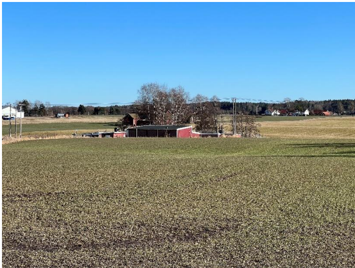
Figur 16: Författarnas bild på avloppsreningsverket i Sollebrunn.
