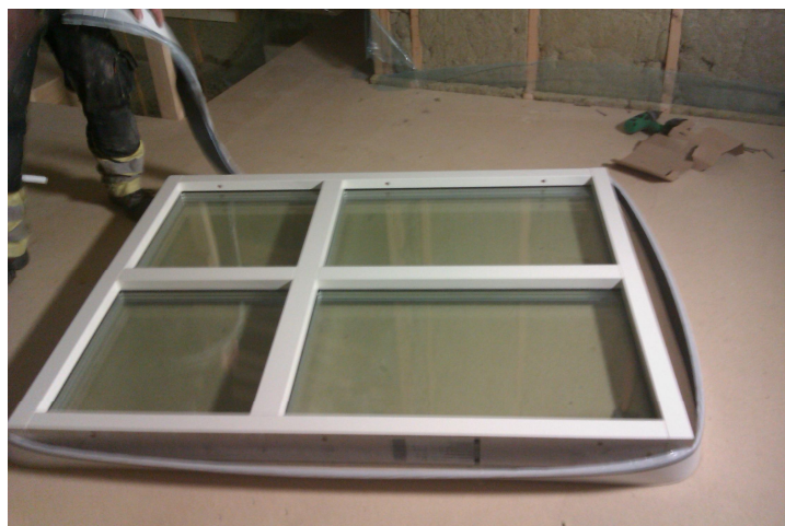
Figur 2.4. Montering av T-drev runt fönsterkarmen innan montering i yttervägg, (Studiebesök Gråbohöjd, 2011).
