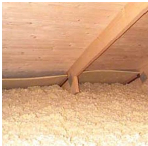
Figur 2.8. En uteluftsventilerad kallvind med lösullsisolering på vindsbjälklaget. Här kan man se vindavledare som avslutas en bit ovanför lösullen. Detta för att skydda isoleringen från inblåsning av luft, (SP, Fuktsäkra Byggnader).
