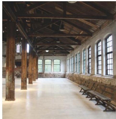
Fig. 31. Strömsfors bruk interior, 2022
