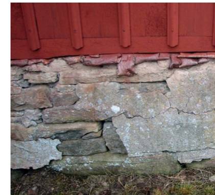
Figure 12. Raised granite foundation (slöjd och byggnadsvård, 2021).
