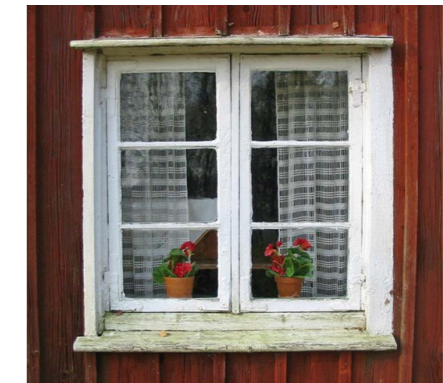
Figure 13. Single glazed window with interior winter pane (slöjd och byggnadsvård, 2021).
