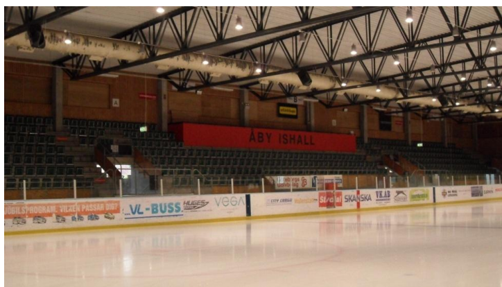
Figur 4: Läktaren mitt emot kafét. Tilluftskanalen ovanför denna läktare är ännu inte isolerad.
