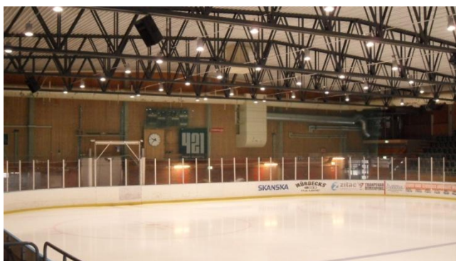
Figur 9: De tre frånluftsdonen sitter i taket ovanför isplanen mitt emellan de två tilluftskanalerna.
