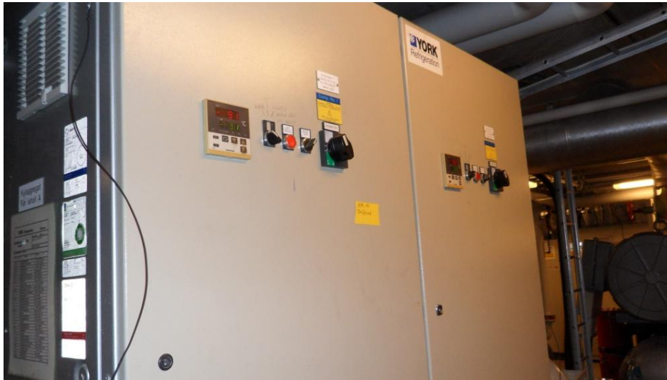
Figur 12: Apparatskåpet till kylaggregatet, ett vätskekylaggregat, som försörjer ispisten med kylt köldbärare.
