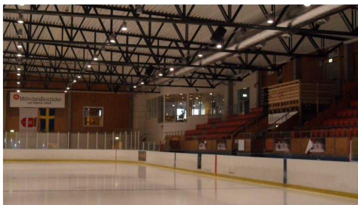
Figur 5: Läktaren i anslutning till kaféet i den nya tillbyggnaden. Tilluftskanalen ovanför denna läktare är i stort sätt färdigisolerad. Jämför även med Figur 8 på sidan 6.
