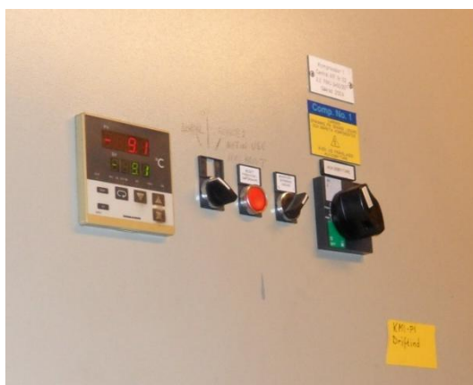
Figur 8: Den digitala termometern på kylaggregatet bildar en del av aggregatets styrsystem.
