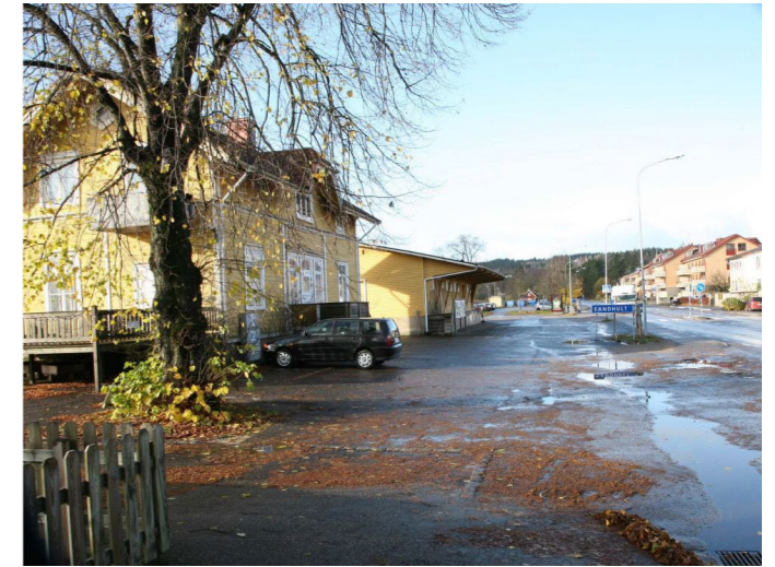
Fig 4.4 : View of the existing Stationhuset and Magasin from Boråsvägen towards Göteborgsvägen. Source : Borås Municipality
