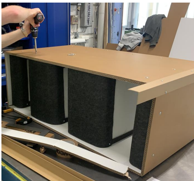
Figur 1010: Infästning av hörn och akustikkulisser.
