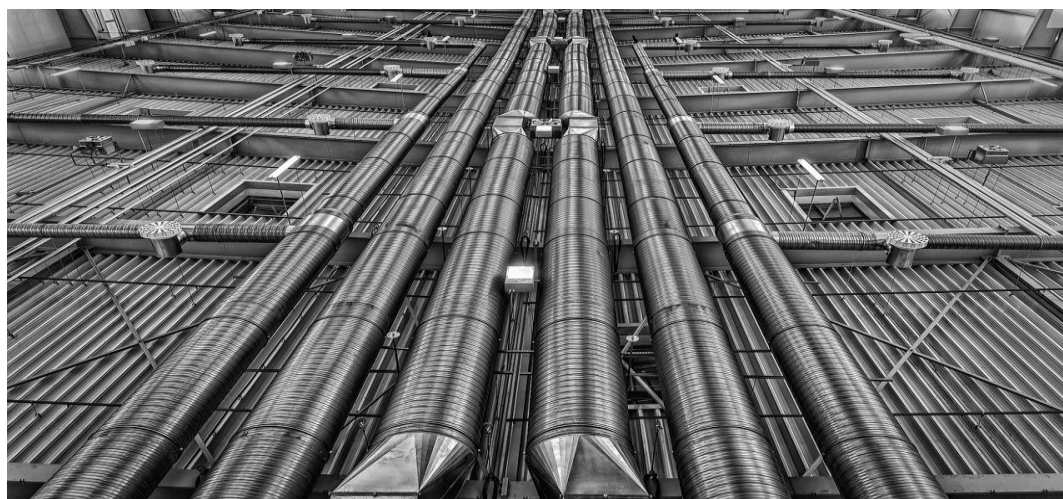
Figur 1: Installerade stål kanaler.
