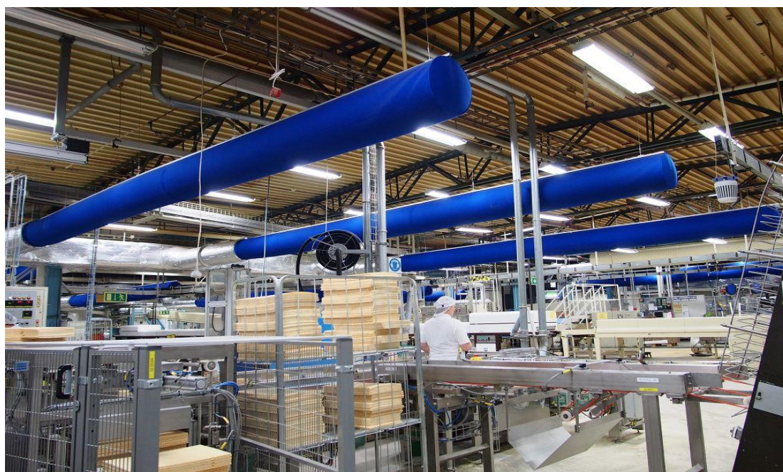
Figur 33: Installerade textilkanaler i Göteborgskexs fabrik av ACP.
