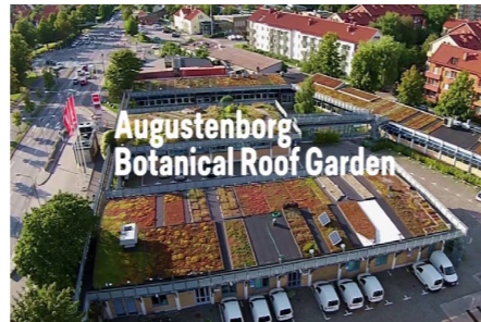
Figure24. Augustenborg (Site: Malmö, Sweden)
