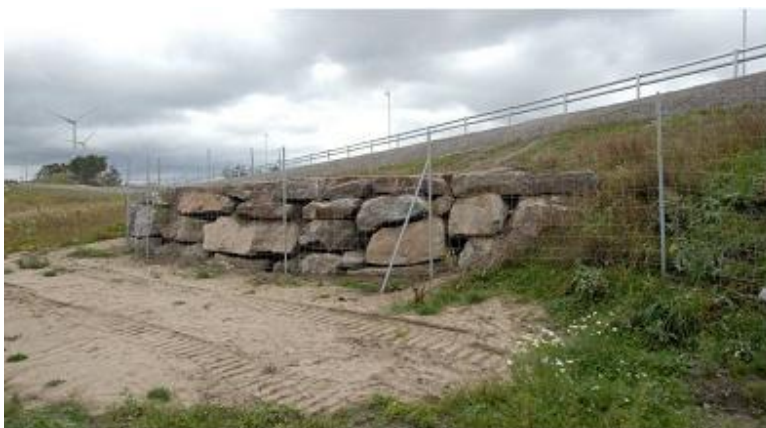
Figur (DF1).1 Faunastängsel placeras i murens nederkant.
