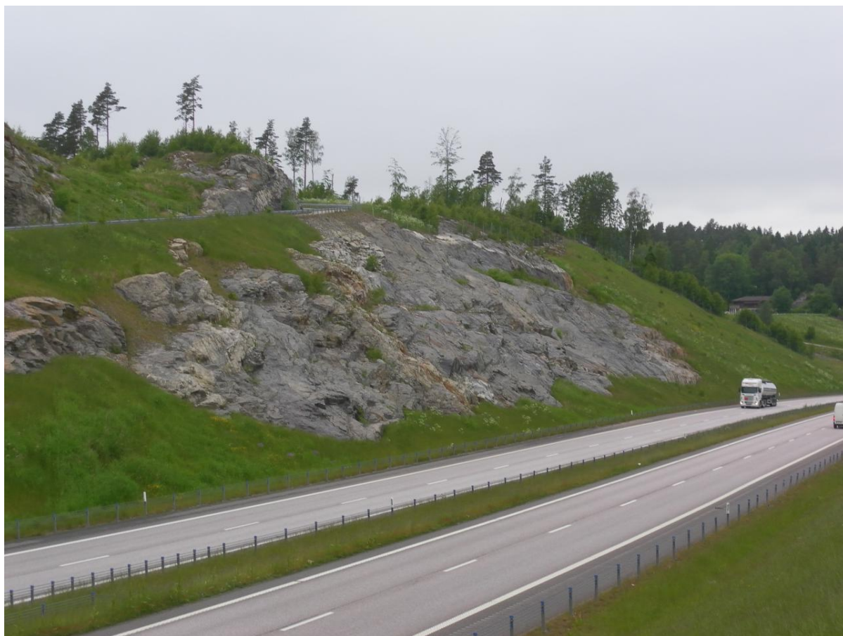
Figur (DB31c).1 Illustration av ambitionen med "naturliknande" bergskärningar, exemplifierat med passage längs Väg E6 i Småröd, söder om Munkedal. Här har en anpassning till och ett arbete med bergets naturliga foliering och sprickor gjort det möjligt att skapa en skärning som berikar vägrummet visuellt, jämfört med såväl en brantare traditionell bergskärning med synliga borrhypor, eller en flackare bergskärning men som senare täckts över (jfr den gräsbevuxna slänten där det synliga berget slutar i bildens högra del).
