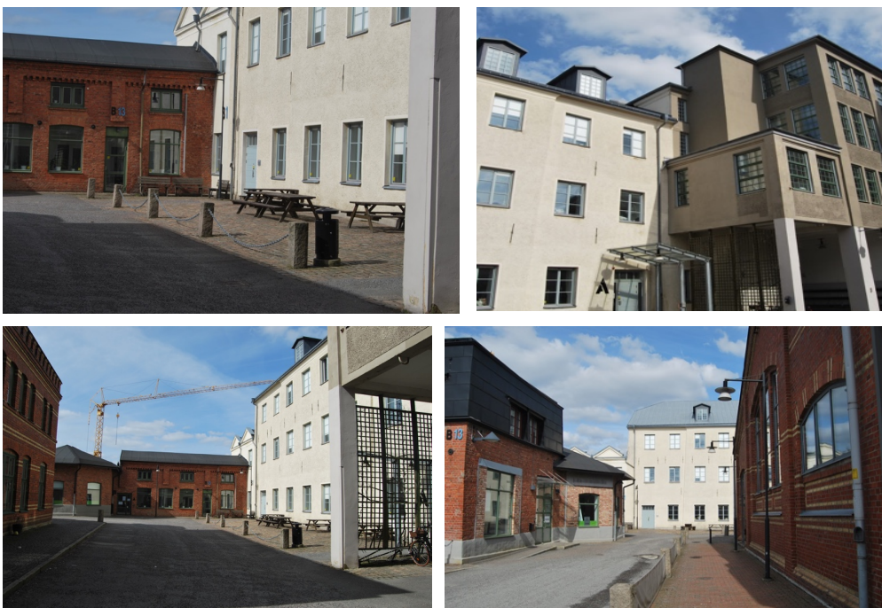
Figur 52. De olika byggnaderna kring Hotspot 2 (Eget foto).
