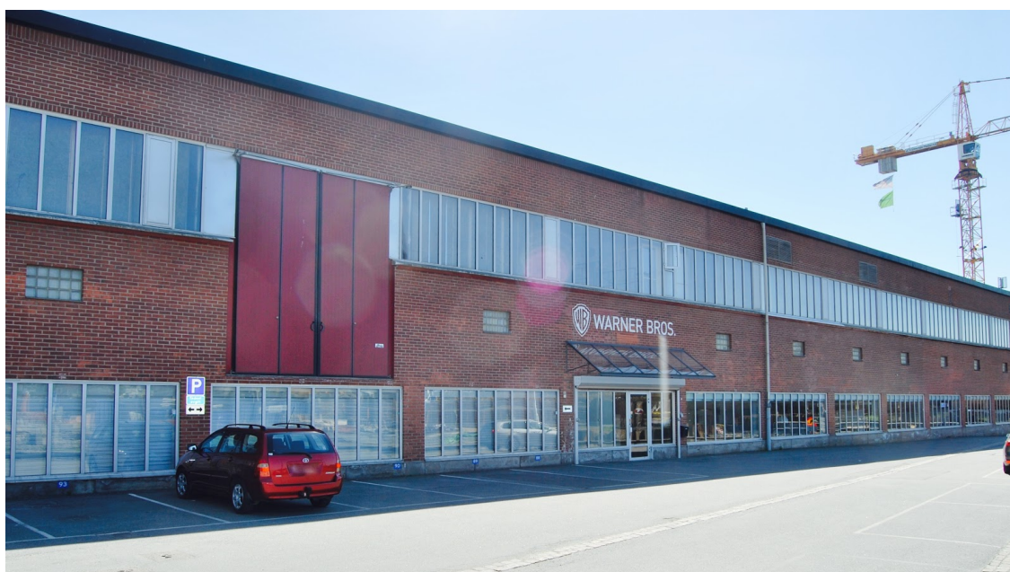
Figur 39. B18 sett från öst vid Sävån (Eget foto).
