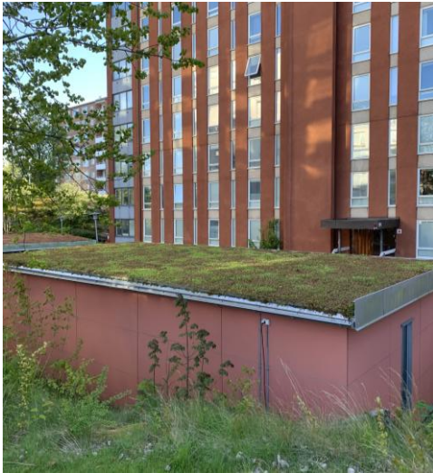
Figur 4 Extensivt grönt tak på returnrum Emilsborg, Göteborg. Bild av författarna.
