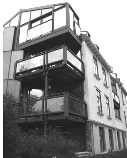
Figur 6: Byggnadens sydvästra hörn. Den södra fasaden är vänd mot hamninloppet.
