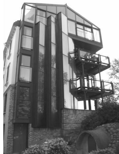
Figur 8: Ekohuset utgör sista delen på längan av landshövdingehus och antar här en mer modern arkitektur. På gaveln är solfångaren placerad. I förgrunden anas jordkällaren.
