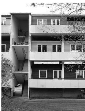
Fig 5. Däckshuset exterior (GP)
