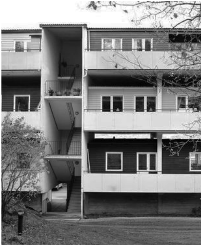
Fig 5. Däckshuset exterior (GP)
