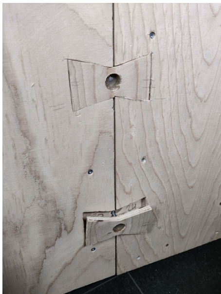
(a) Laxstjärtskoppling i demonteringsfas
