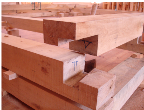
Figur 22: Hörnskarv mellan stockar (Ulrik Hjort Lassen, 2009)
