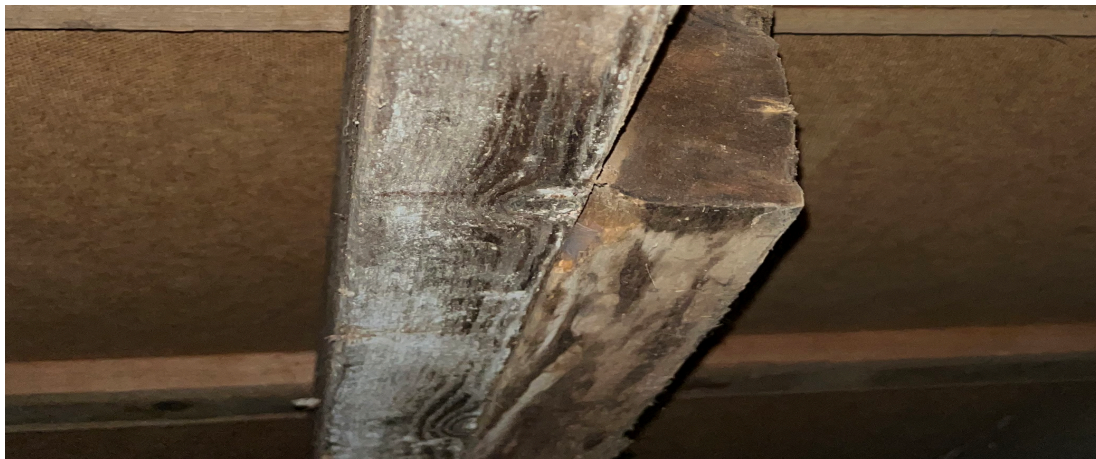
Figur 6.2.1B Begynnande mikrobiell påväxt på bärlina vid mät punkt 5A. Fotot är tagit 2023-03-21.
