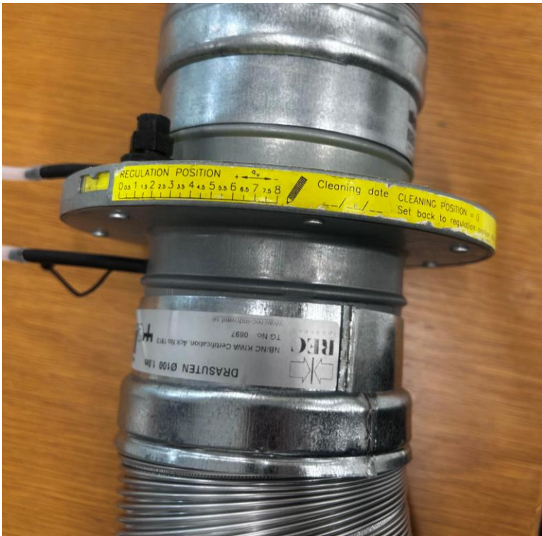
Bild 4.6: Spjäll av modell IRIS 100 ORIGINAL
