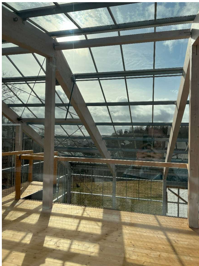
Bild 9: Foto från insidan av huset på övervåning (Niemer & Schulz, 2023).
