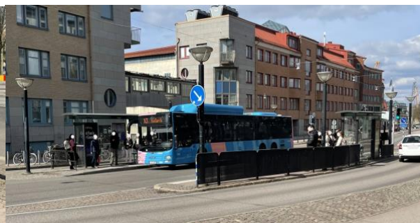
Figur 12, staket vid hållplats Pilgatan.
