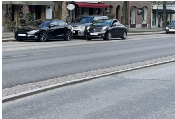
Figur 7, upphöjd gatsten i förhållande till bilkörfält.
