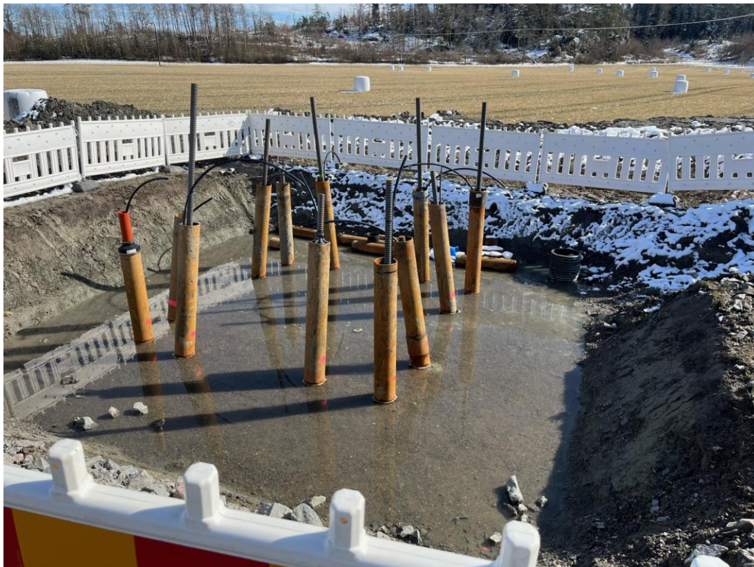
Bilaga 5: De nedborrade pålarna med stag innan de kapas (Bild tagen från platsbesök med tillåtelse)
