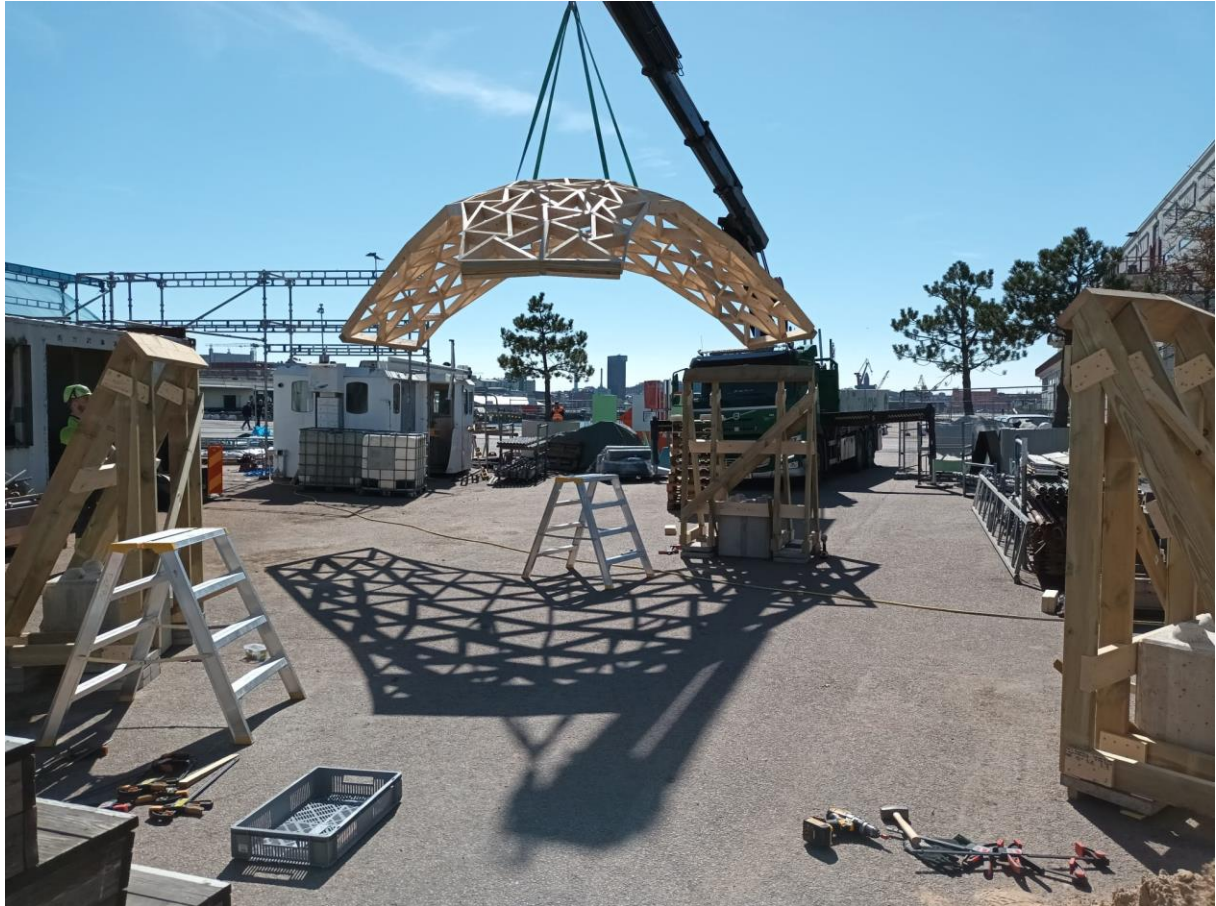
Figur34. Kran som lyfter paviljongen över dess tre stöd.
