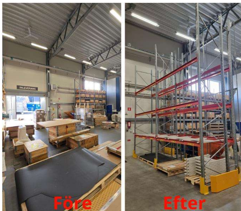
Figur 4.3: Bilden visar före och efter installation av stället vid godsmottagning
