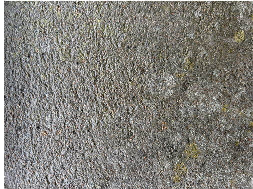
Figur 5.7: Visuellt underlag i samband med mätning av blöt betongyta
