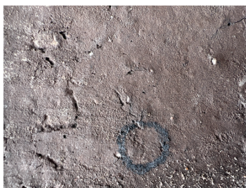
Figur 5.2: Visuellt underlag i samband med återkommande mätning av tegelvägg
