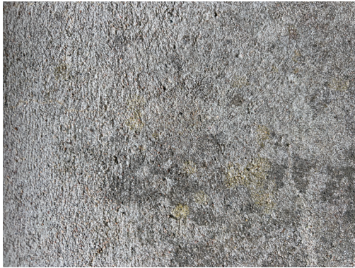
Figur 5.6: Visuellt underlag i samband med mätning av torr betongyta
