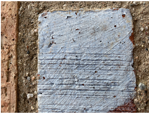
Figur 5.12: Visuellt underlag i samband med mätning av ljusblåmålad tegelvägg med tunt lager färg.
