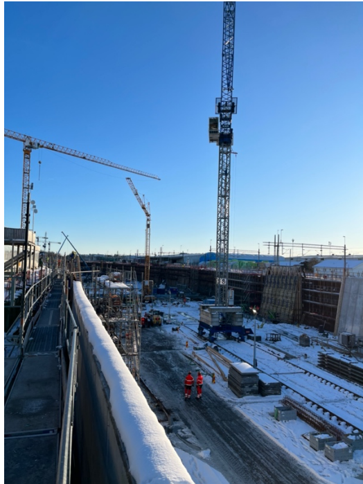
Figur 1. Bild över arbetsområdet i det norra betongtråget.
