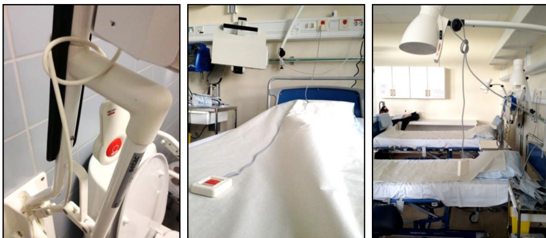
Figur 2.3 Positionering av larmdosa i vådrummet
