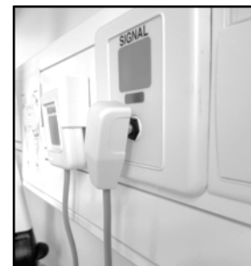
Figur 2.13 Kontakt som blivit utdragen ur uttag
