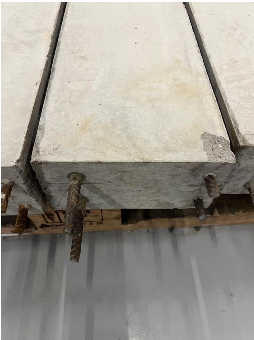
Figur D.5 Utstickande armering för balk B-11.
