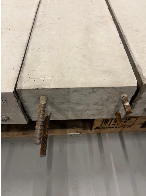
Figur D.4 Utstickande armering för balk B-10.
