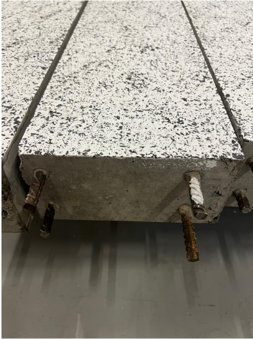
Figur D.2 Utstickande armering för balk B-05.
