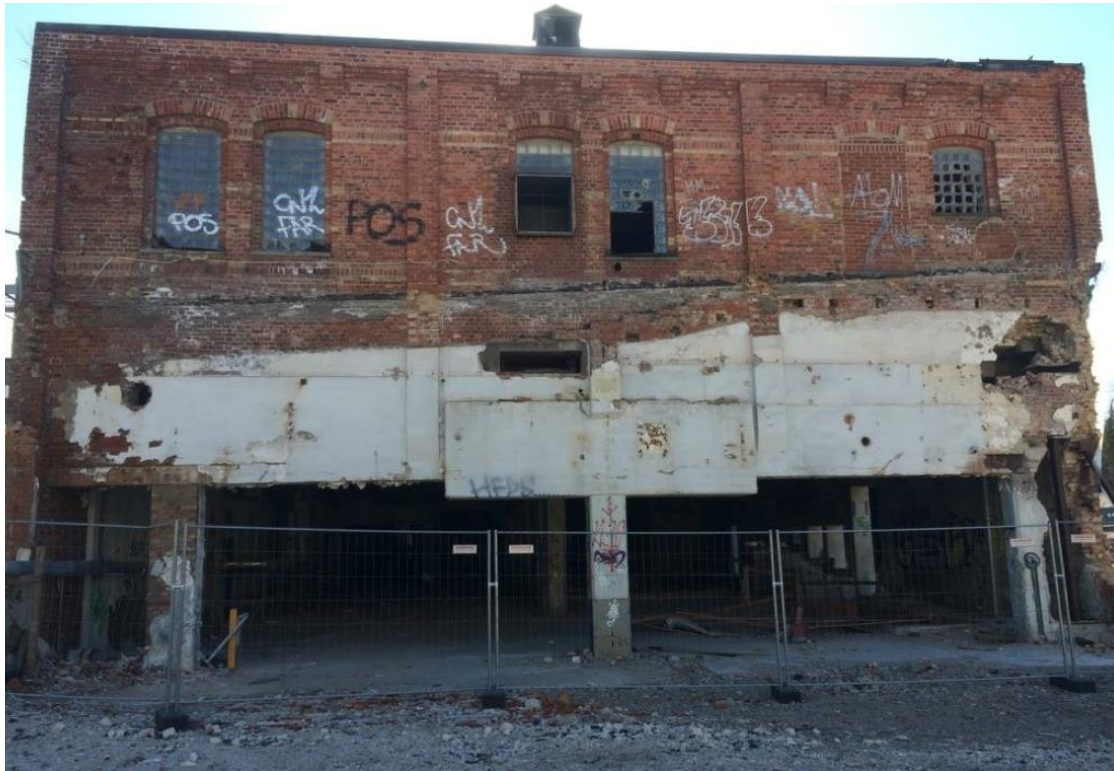
Figur 9. Östra fasaden som visar på tydligt bevarad arkitektur på plan 2 samtidigt som plan 1 visar på dramatiska förändringar utförda under 1900-talets senare del (Zynka BIM, 2019). Återgiven med tillstånd.
