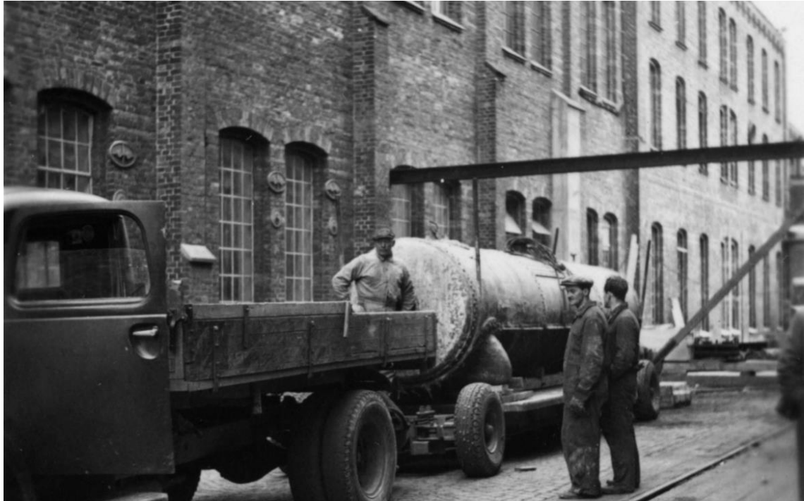
Figur 6. Arbetare framför byggnad 10 där byggnad 2 skimtas till höger (Mölnalds stadsmuseum & Föreningsarkivet i Sydvästra Götaland, 1949). PDM.
