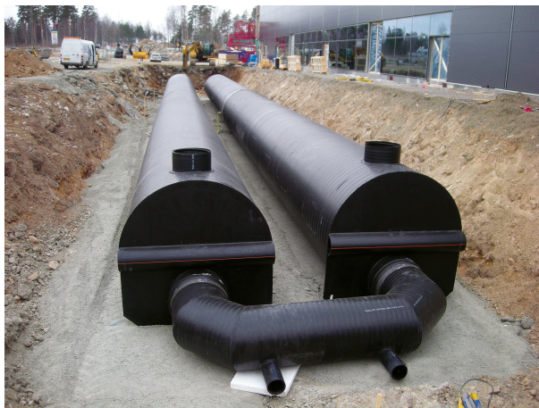
Figur 7: Dagvattenkammare/rörmagasin (Bick, 2016).
