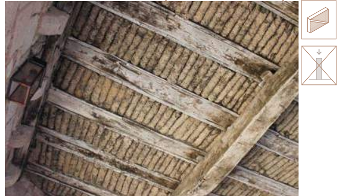
Image 35. Deck underside (Région Nouvelle-Aquitaine, Inventaire général du patrimoine culturel – Baptiste Quost, 2012)
