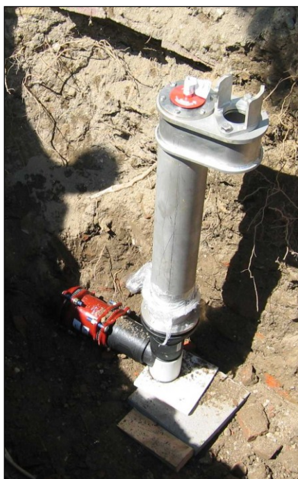
Figur 11 – Montering av brandpost i fält
