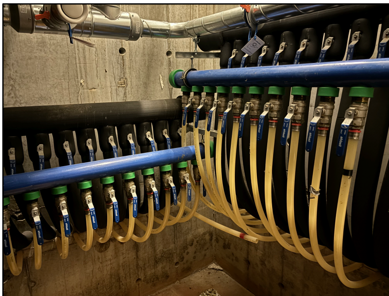
Figur 4. PEX-slangar som går ner i stenmjöslagret på Fredriks yrkesgymnasium. FOTO: Dennis Lind
