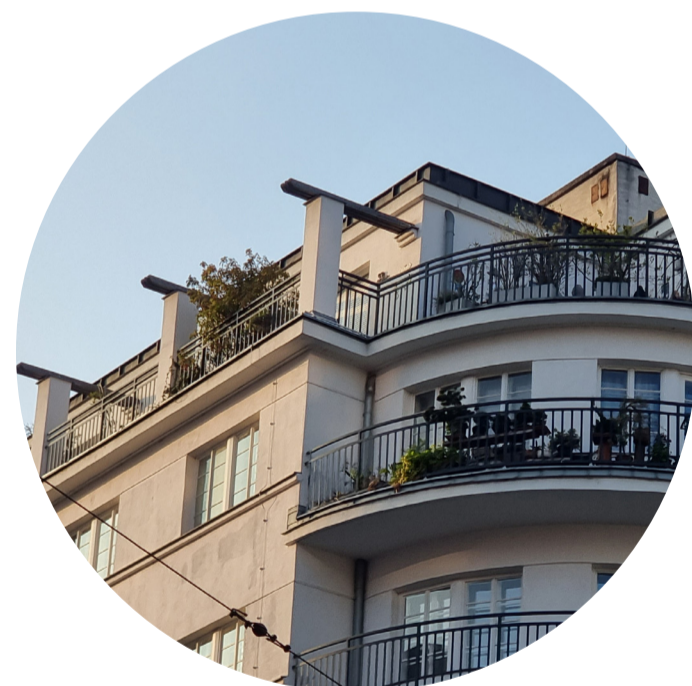
Indragna takvåningar för balkonger på taket
