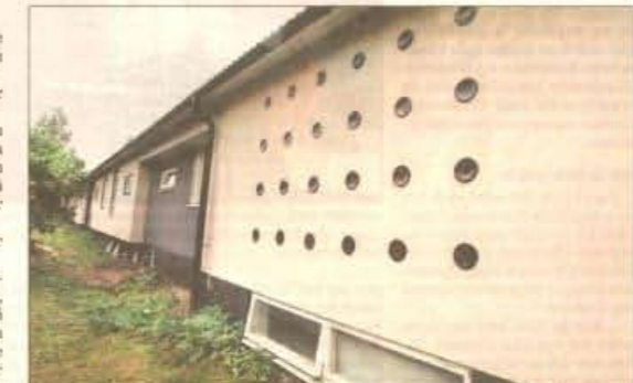
FLASKBOTTNAR. De små runda fönstren kan man hitta överallt i Gästrike-Hammarby och också i Erskines arbeten på andra håll i världen. Här har han använt flaskbottnar från det lokala bryggeriet som fönsterglas.
