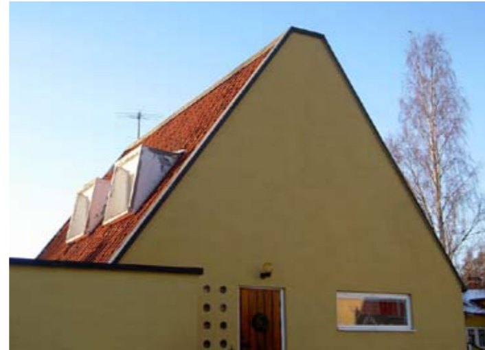
Byggnadstradition som ursprung i formspråket. Sluten fasad mot gatan.
