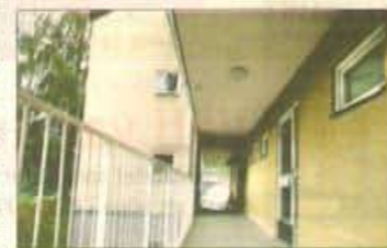
HISS. I trapphuset ska en av de större förändringarna äga rum. Här måste en hiss installeras. "Många av våra blivande hyresgäster är äldre, som inte orkar med sina hus längre", säger Mats Mattsson.
