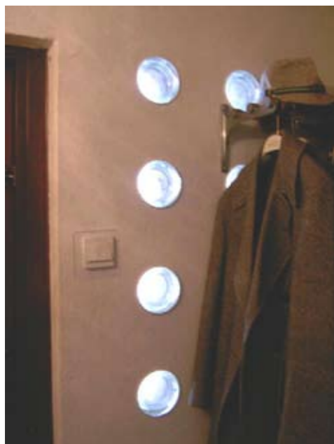
Tolv cirkelformade ljusinsläpp på vertikalen i hallen.
