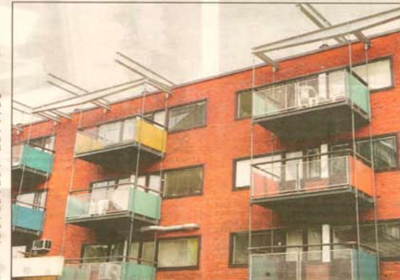
GJORDE OM. I Sandvikens centrum finns många hus signerade Ralph Erskine. De här husen, vid Knutentorget, blev Erskine aldrig nöjd med och ett av hans sista arbeten innan han avled var att göra förändringar av balkongerna.
