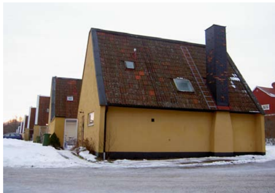
Exteriört är murstocken utmärkande i norrfasaden.
