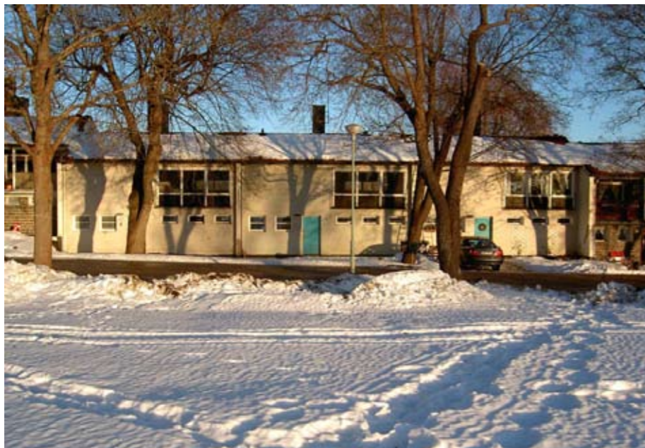
Tre av Långbos lägenheter har en avvikande fasad i naturvit puts, vilket ger variation och spänning i uttrycket.
