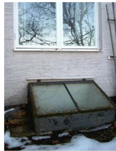
Glaskupa för ljusinsläpp i källarplan, påminner om ett kolnedkast enligt engelsk tradition.
