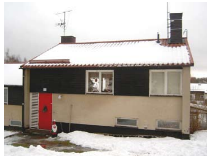
Putsad fasad ihop med liggande panel. Ytterdörrarna i klara kulörer.
