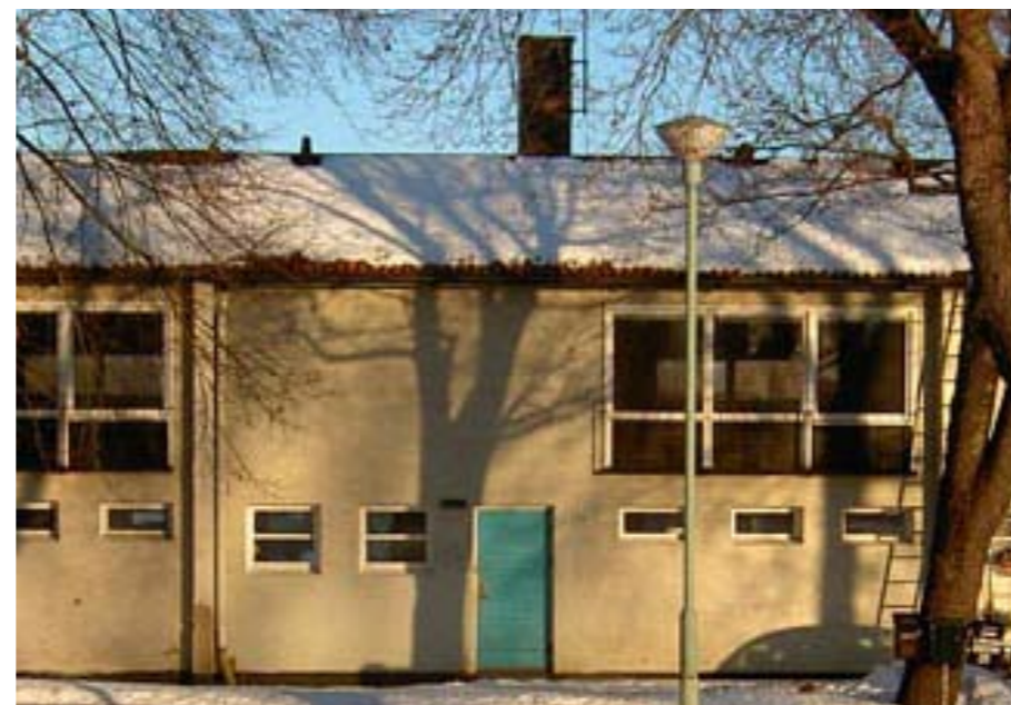
Fasaduttrycket är avsevärt enklare än de övriga lägenheternas. Fönstersättningen har dock sina likheter, med undantag för övre plan som är mer sluten. Genom att fasaden inte är indragen saknas balkonger. Det ger en något rymligare planlösning. Ytterdörrarna är målade i en klart turkos kulör.
