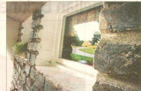
STEN FRÅN BRUKET. Erskine plockade upp många av de lokala materialen i sin arkitektur. Här, på radhusen i "Långbo", har han använt slagsten från järnbruket på husens nedre plan.
