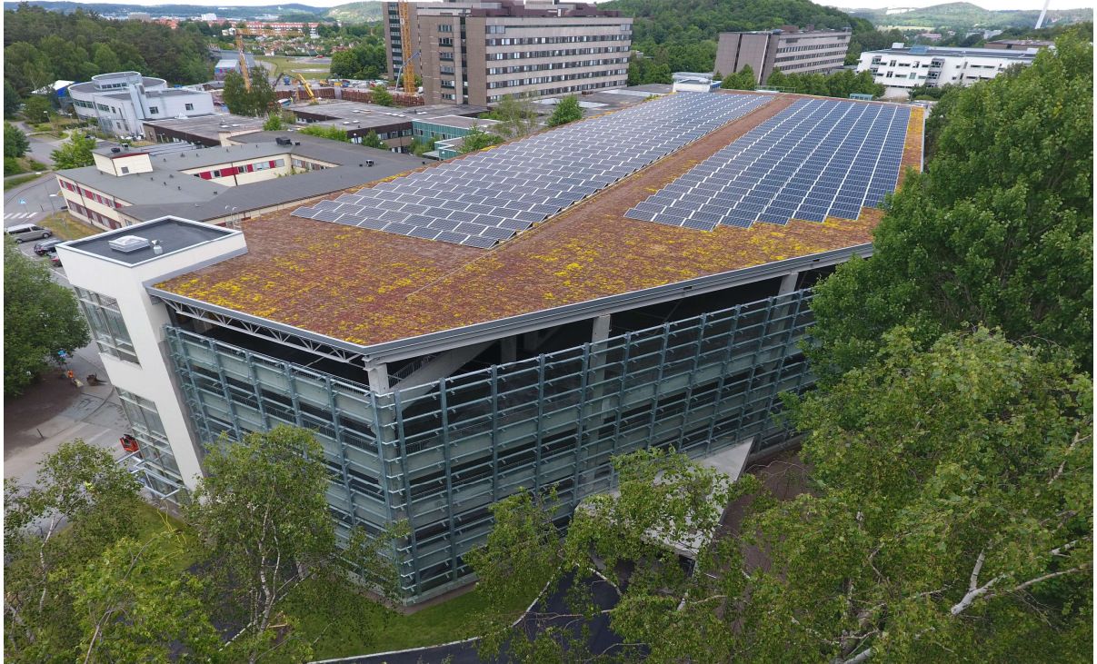
Figur 25. Östra sjukhuset parkeringsgarage (LM Stålmontage AB, 2017)
