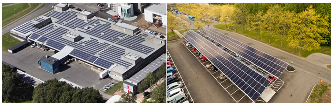
Figur 26. Solceller Skaraborgs sjukhus Skövde (Västfastigheter, 2017)
