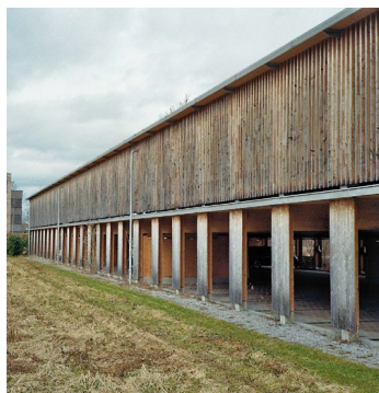
Hermann Kaufmann Holzparkdeck Bad Aibling, Germany.
