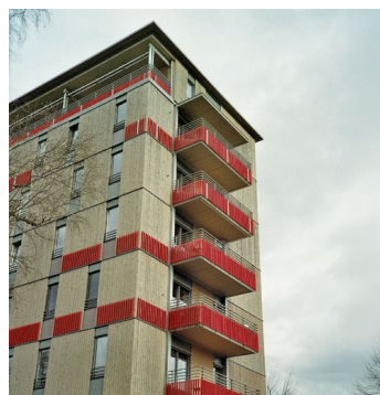
Schankula Architekten Holz 8 Bad Aibling, Germany.
