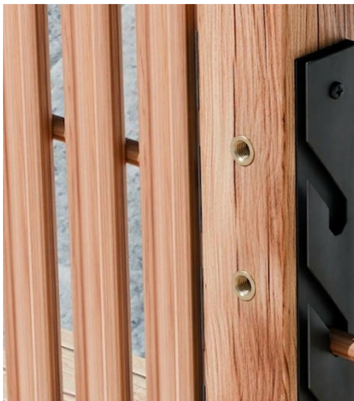
Figur 12: AI-korrigerad bild av gänginsatser i pelare (Korrigerad med Gemini)
