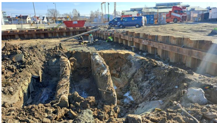
Figure 14: Earthworks phase at Solhøjden. (JM, 2025a).
