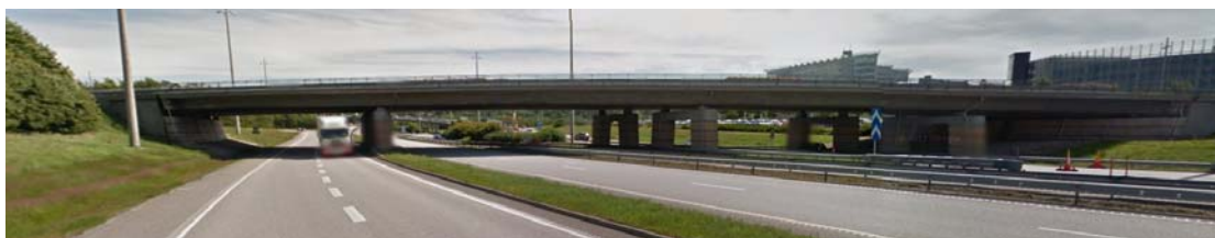
Figur 5.2 Vy från västra sidan av bron (Google street view).
