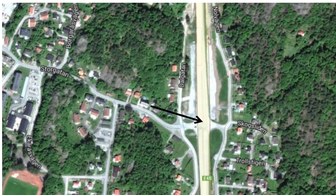
Figur 5.6 Pilen markerar platsen för Bro II. Bilden är tagen innan ombyggnaden av E45:an (Google maps, 2014).
