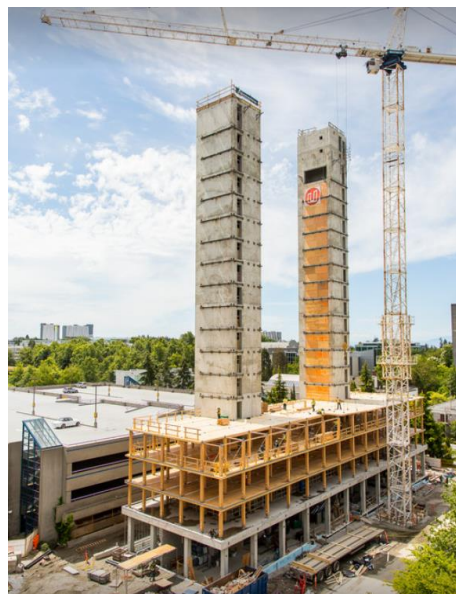
Figur 6. Brock Commons med betongkärnor (Elkan, 2018).
