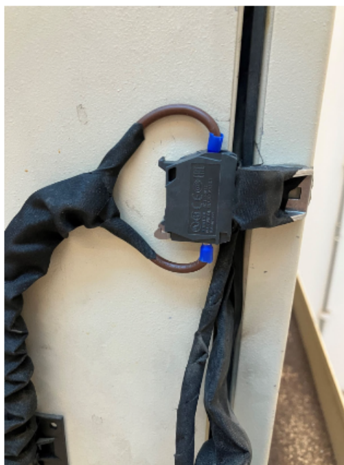
Figur 4.17: Placering av kontaktor
