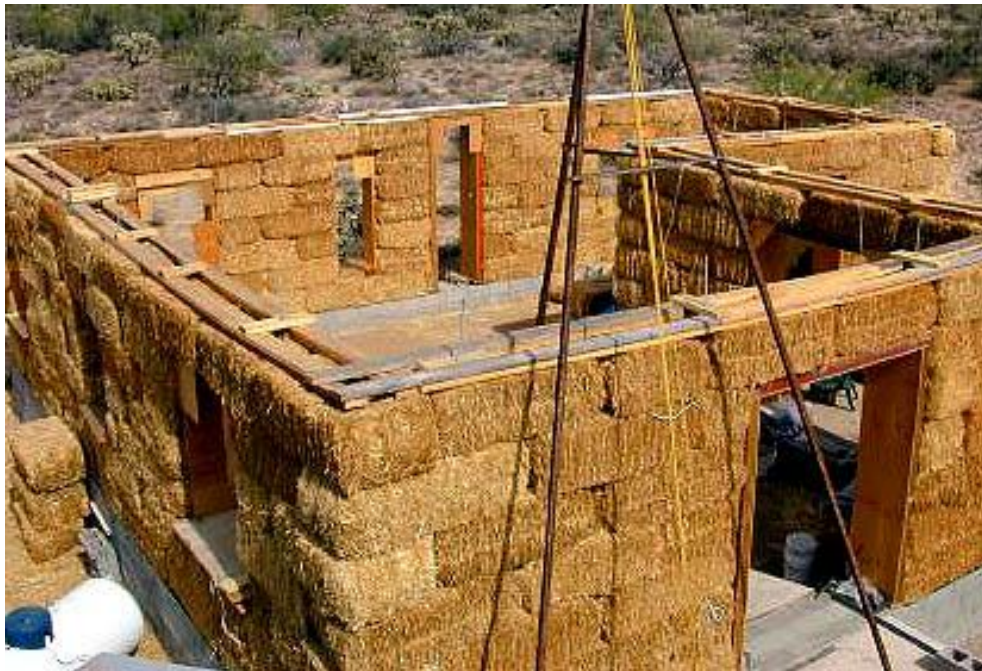
Figur 8 - Staplad halmbalsvägg med hammarband på.
