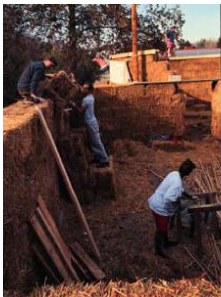
Figur 5 - Studenter bygger en självbärande halmbalsvägg.
