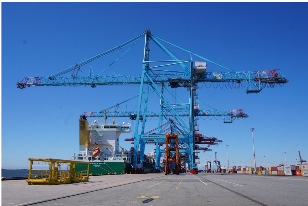
Figur 4.2. Överblick av terminalens maskiner, kran K14 och 4H-truck, författarens egen bild (2019).
